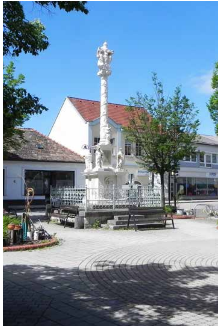
Pestsäule nach der Renovierung 2015/16
