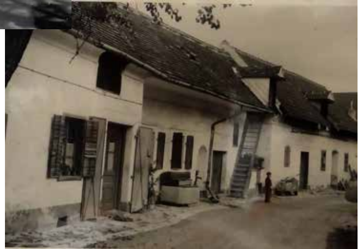
Der Hof vom Kitaibelhaus
