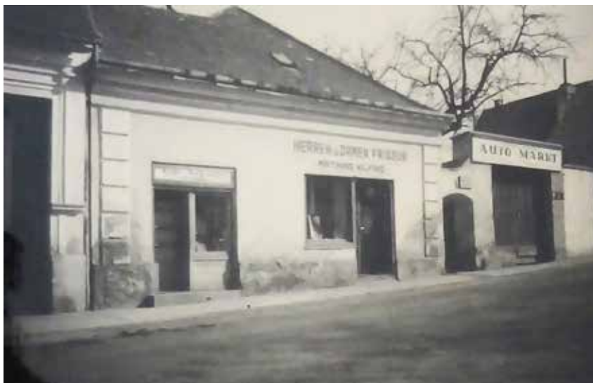
Das Haus nach dem Umbau
