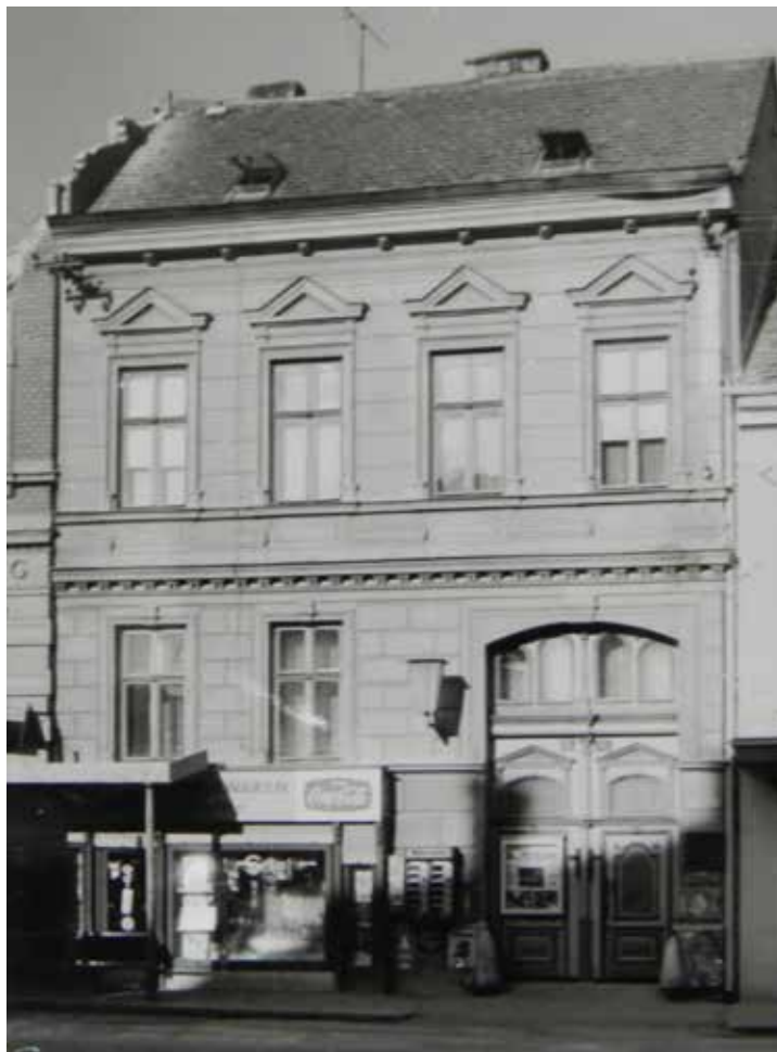
Das Lorenz-Haus kurz vor dem Abriss.
