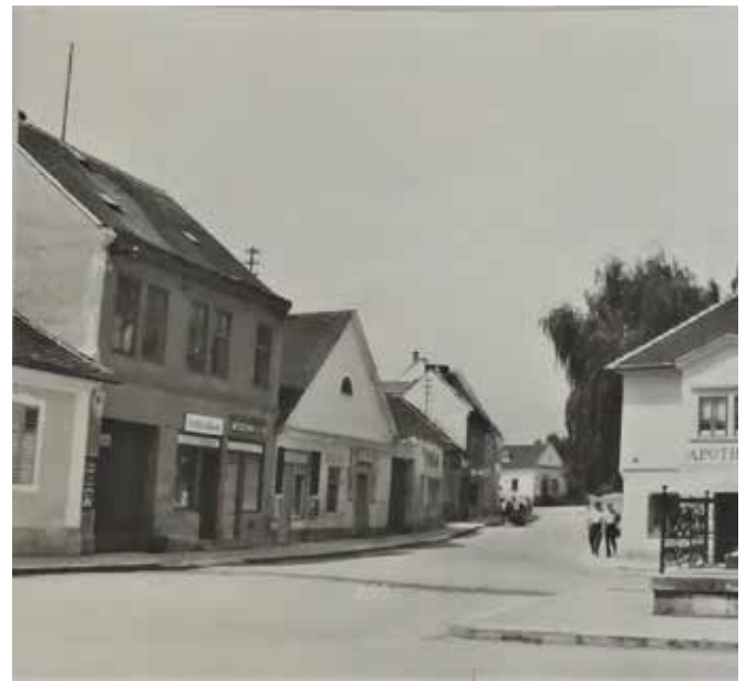
Lebinger Häuser - auf einem Teil des Grundstückes wird ein Stockhaus errichtet.
