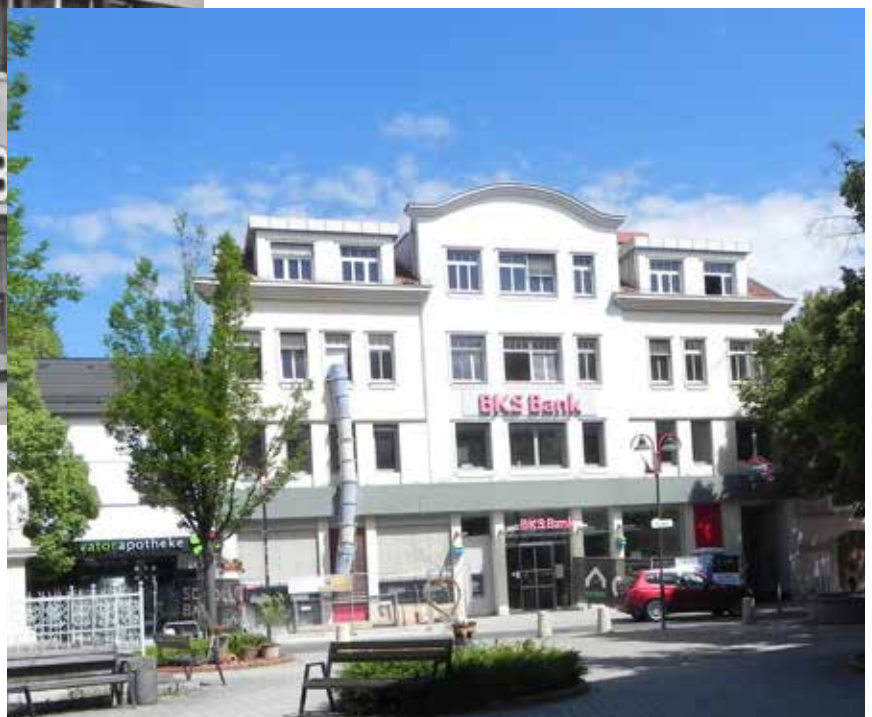
Nach neuerlichem Umbau beherbergt das Bankgebäude die BKS Bank (2024)
