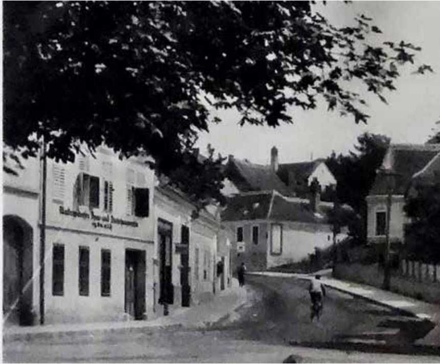
Der Zubau für die Bank
