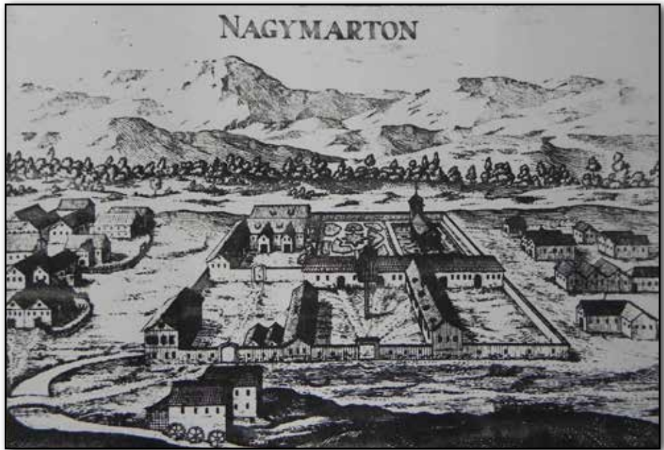
Der Meierhof von Mattersdorf. Im Vordergrund die Hofmühle mit drei unterschlächtigen Mühlrädern
