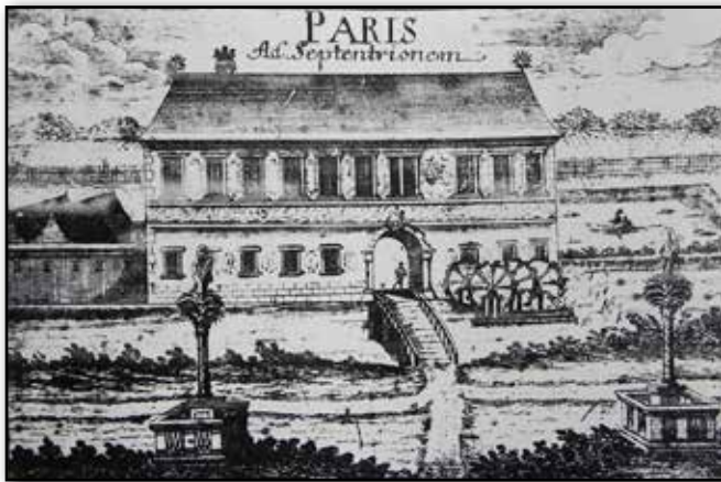
Die Pariser-Mühle in Trausdorf. Sie hieß früher Aumühle und soll bereits 1192 erbaut worden sein.
