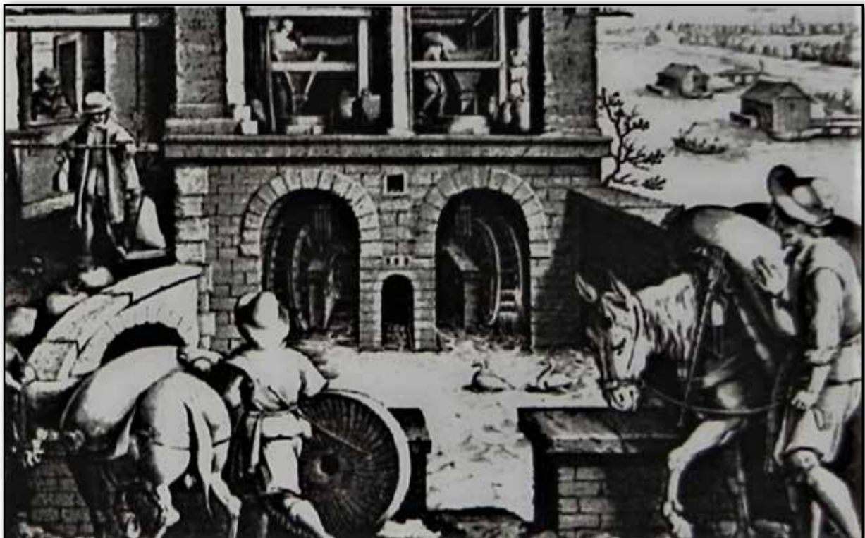
Wassergetriebene Räder treiben die Getreidemühlen an (aus 1555).
