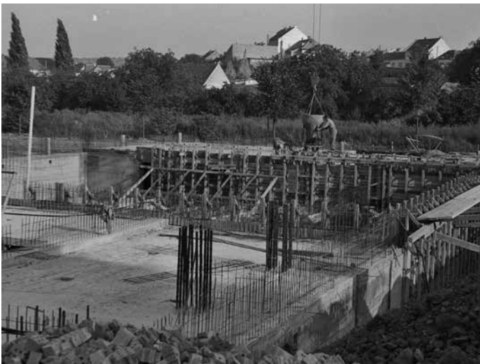
Bauarbeiten am Hochhaus bis zur Fertigstellung,
