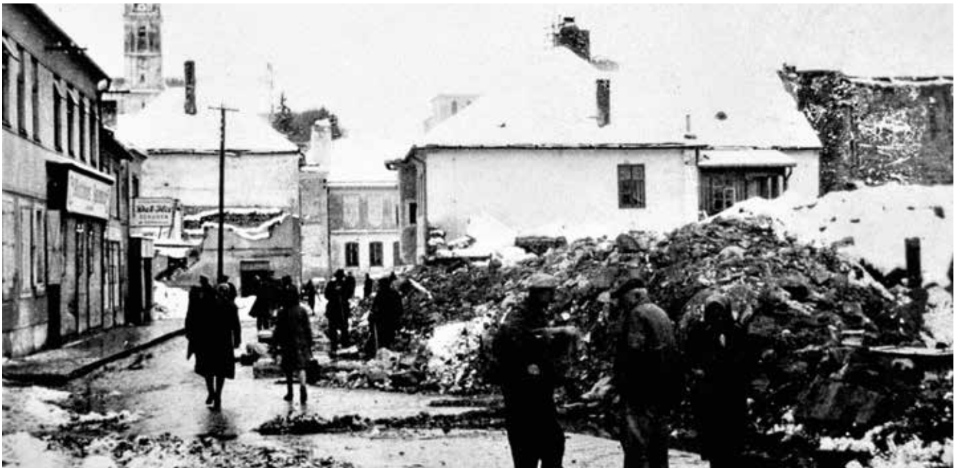
Abbrucharbeiten in der Judengasse
