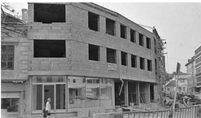
Bauarbeiten Ecke Judengasse/Gustav-Degen-Gasse
