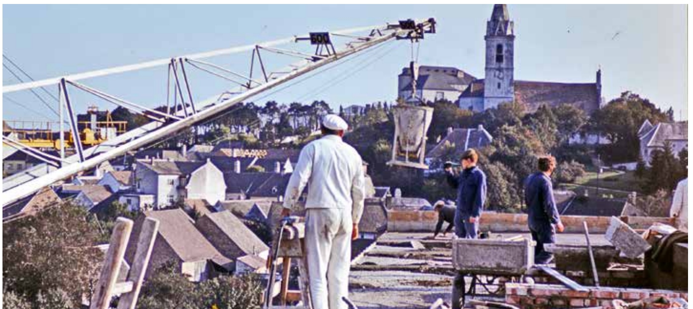
Bauarbeiten, heute Konditorei Harrer
