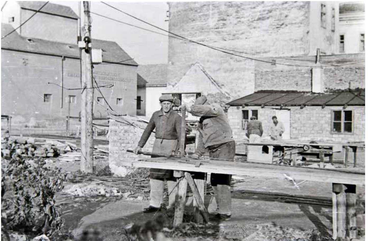
Bauarbeiten Ecke Michael-Koch-Straße/Judengasse, 1956/1957. Schreiner „Der Eisenbieger“
