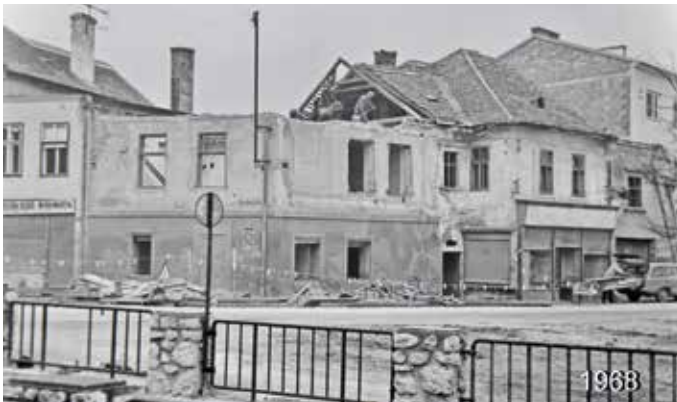
Abbrucharbeiten Ecke Judengasse/Gustav-Degen-Gasse
